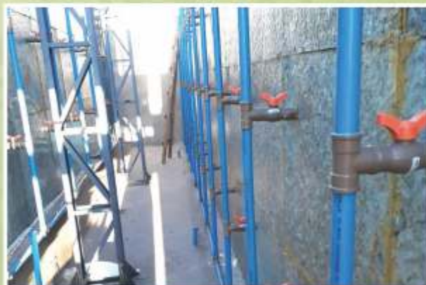
Sistema de Exaustão dos gases.
